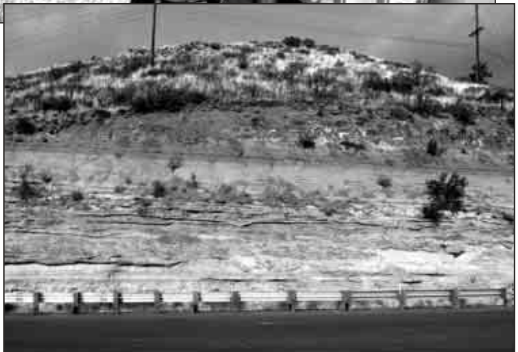
Här ses de geologiska lagren tydligt där man grävt för att göra plats för vägsträckningen.
